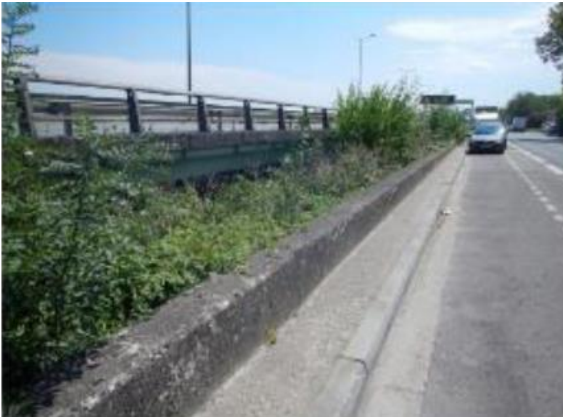
Photographies du muret de protection, source : prédiagnostic
