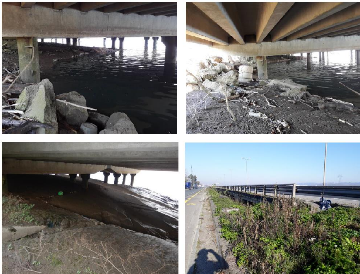
Photos de la zone de projet et de la berge sous l'autoroute ; source : Suez Consulting
