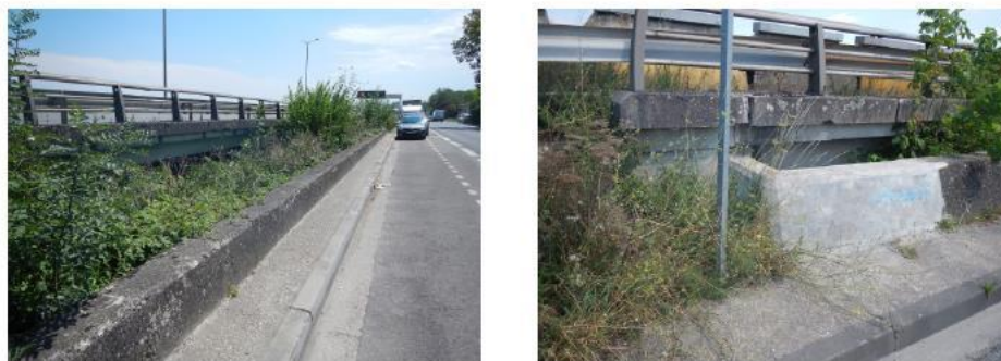
Figure 19 : Murets béton du tronçon 3
